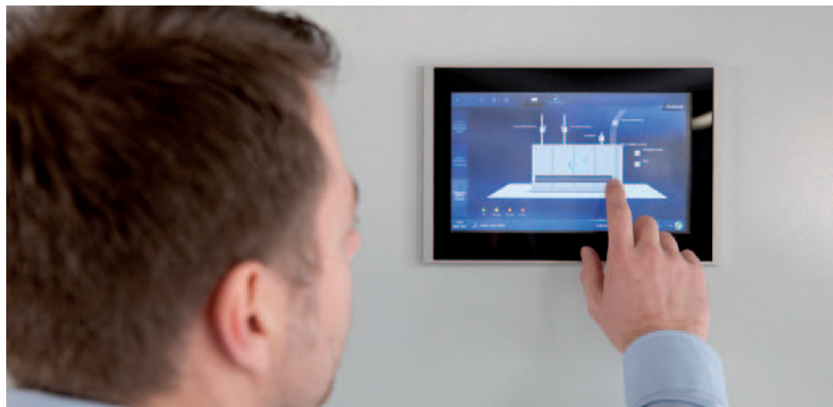
Alles im optimalen Bereich: Über einen Kontrollmonitor lassen sich die aktuellen Daten zum Heizsystem abrufen. Bild: Felix Krumbholz
