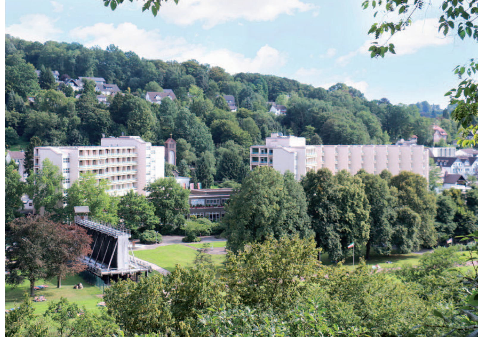
In der idyllisch gelegenen Rehaklinik Carolinum im Heilbad Bad Karlshafen wurde das Heizsystem mit zukunftssicherer und effizienter Buderus Systemtechnik modernisiert. Bild: Greta Peukert
