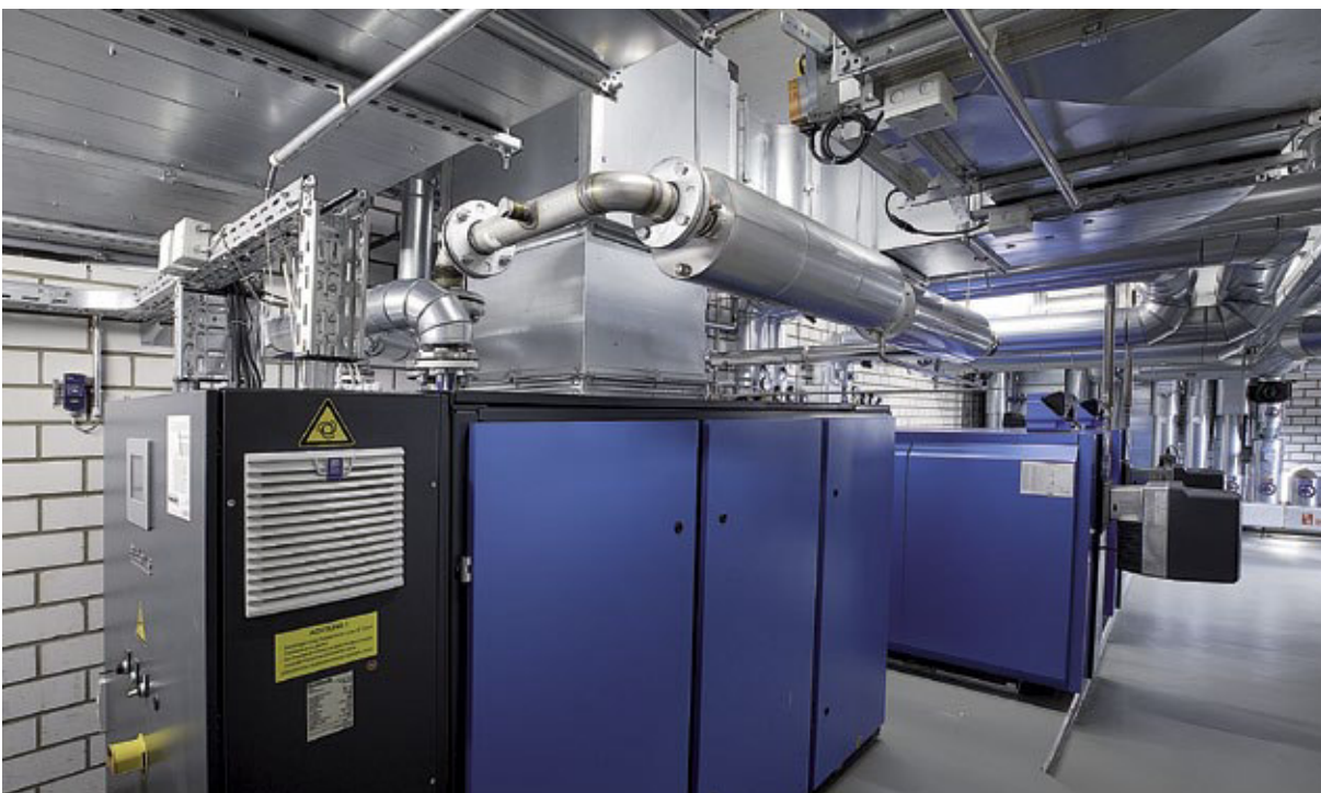
Das Buderus BHKW-Modul Loganova EN50 hat 50 kW elektrische und 79 kW thermische Leistung.
