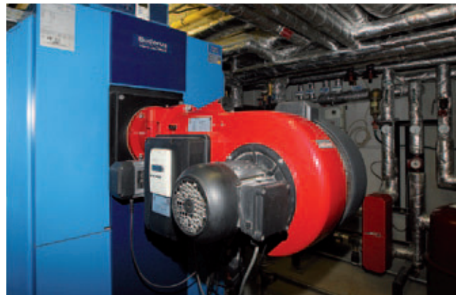
Der Gas-Brennwertkessel ermöglicht mit seinem hohen Wirkungsgrad eine wirtschaftliche Heiz- und Trinkwassererwärmung.
